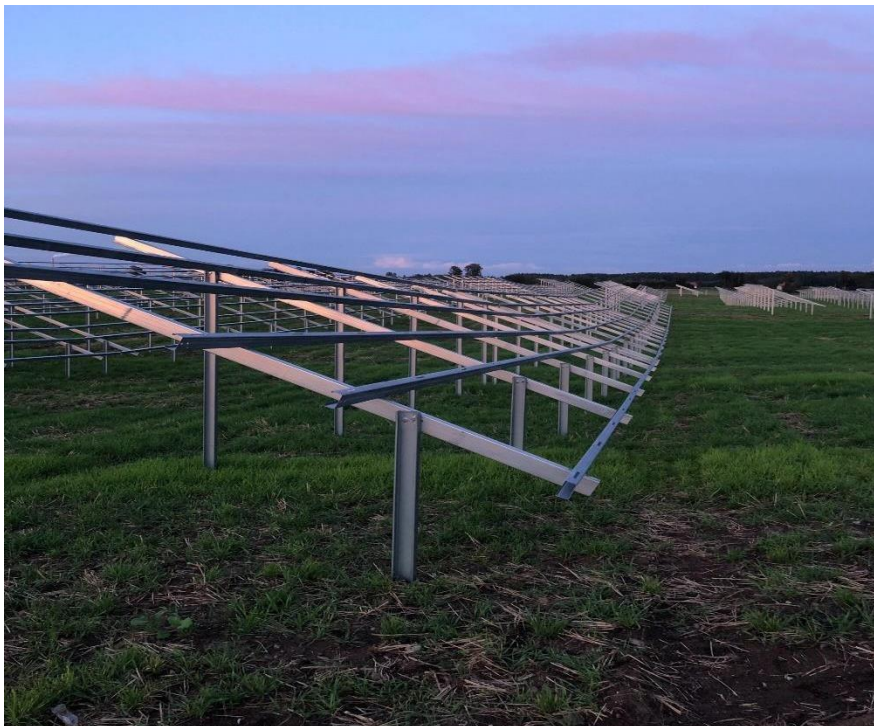
Ryc. nr 8 Przykładowe szkielety przed montażem paneli
