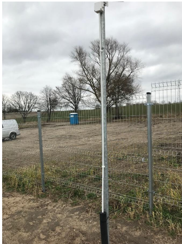
Ryc. nr 15 Przykładowe ogrodzenie farmy fotowoltaicznej
