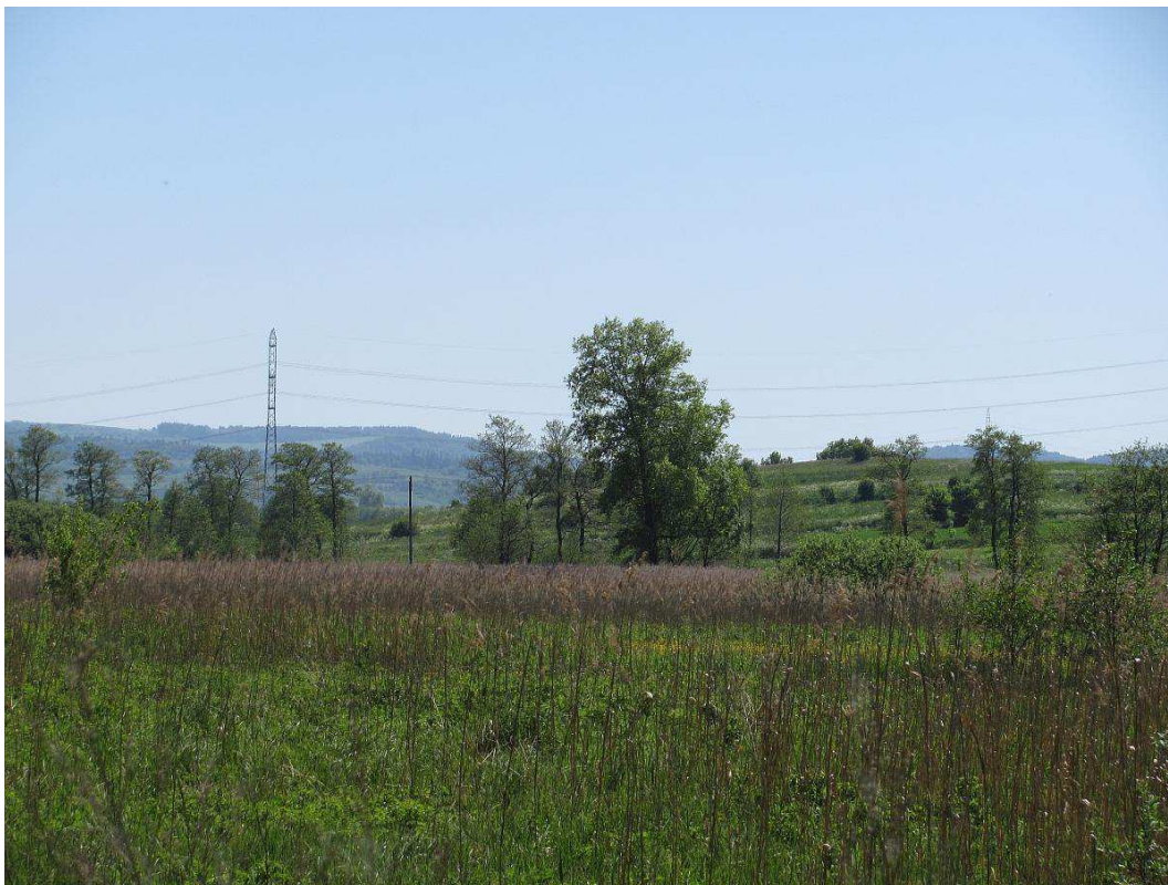
Zdj. 3 Rejon planowanych elektrowni nr EW-14 i EW-15
