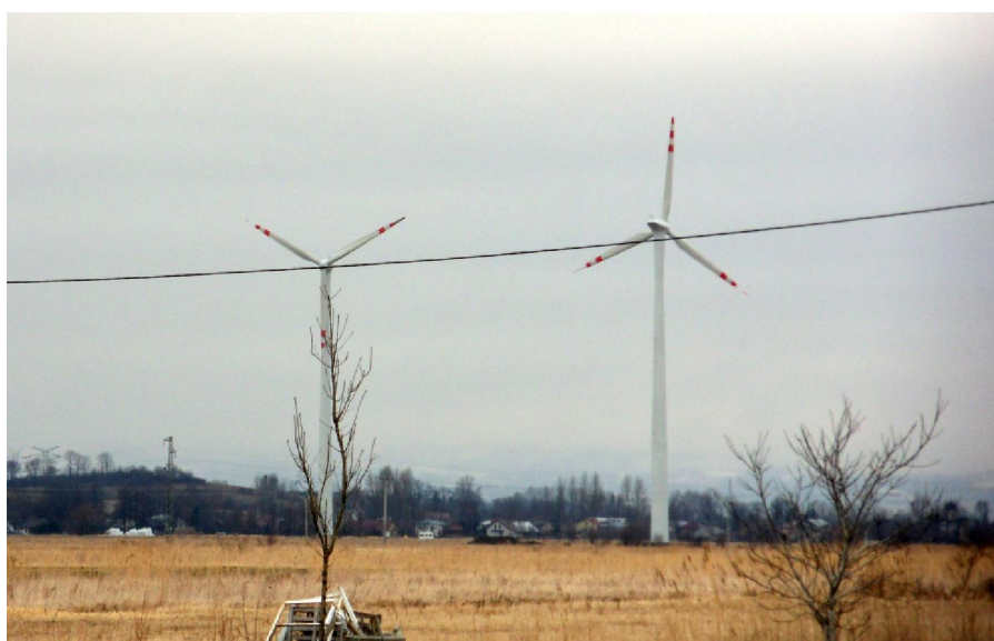
Fot. 6. Nowe turbiny na zachód od Ladzina.
