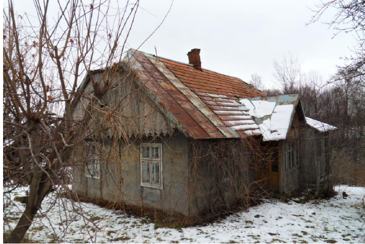
Fot. 26. Opuszczony dom w Łazach - brak nietoperzy (sprawdzono również poddasze – brak guana).
