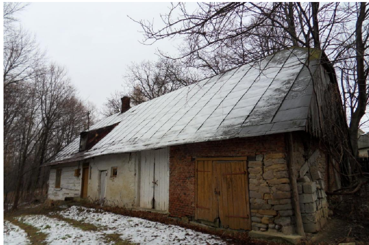
Fot. 27. Opuszczone budynki gospodarcze w Łazach - brak nietoperzy
